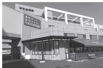
平和台病院(外観)
